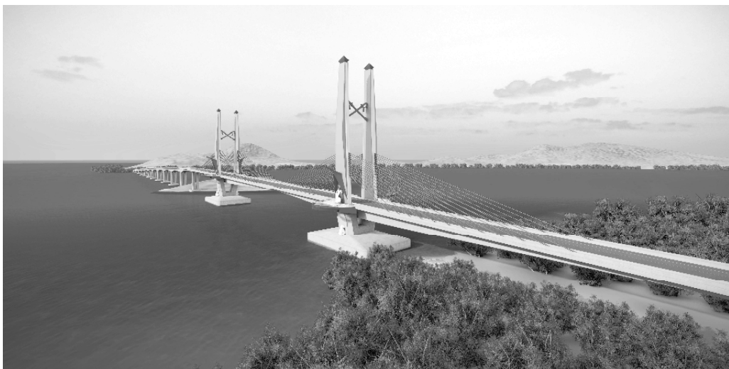
รูปที่ 8-2 รูปแบบโครงการที่เหมาะสม รูปแบบสะพานคนขี่ (Extradosed Bridge)
